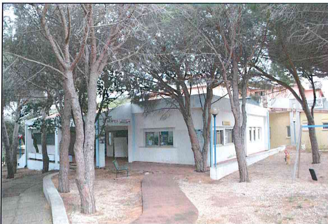
Vista dall'interno del cortile del fabbricato oggetto d'intervento
