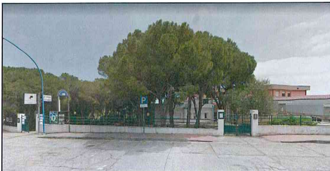
Vista da viale Bue Marino del complesso delle strutture comunali
